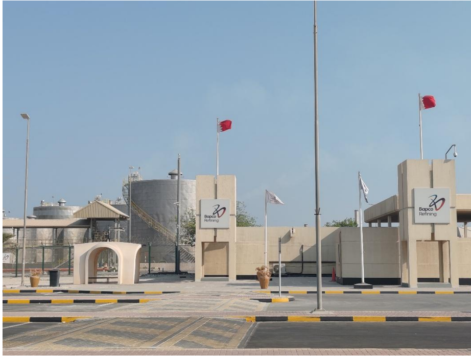
Immagine n. 16 - Bapco Refining (esterno).
